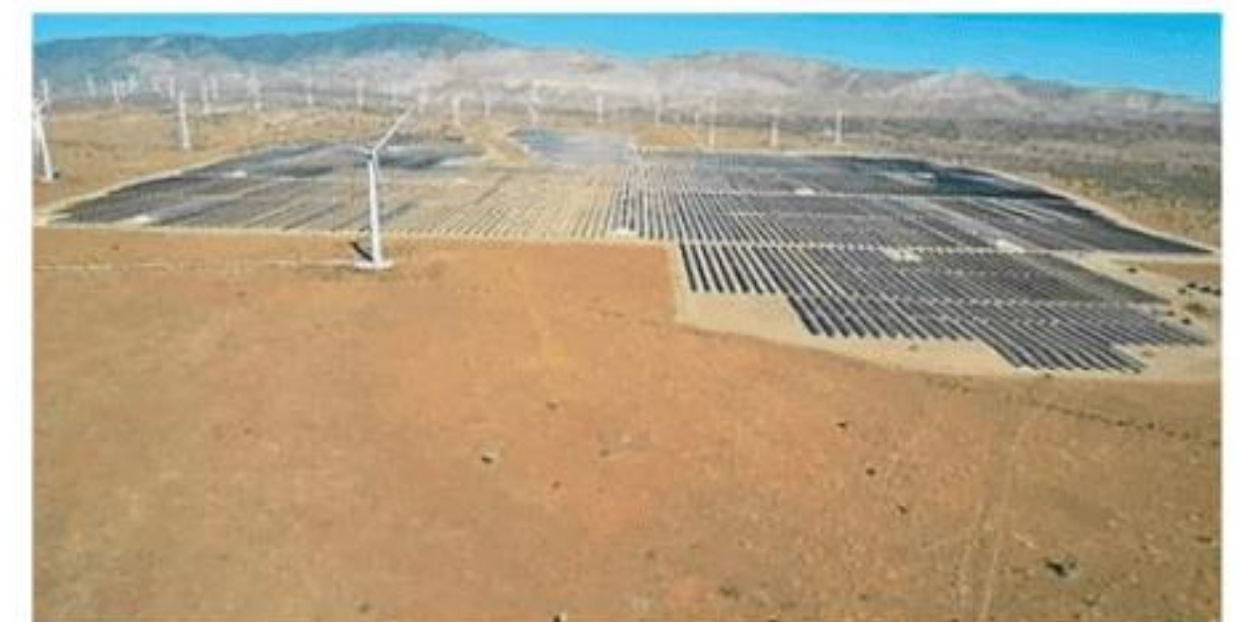
Imagen aérea del nuevo parque solar de Avangrid
